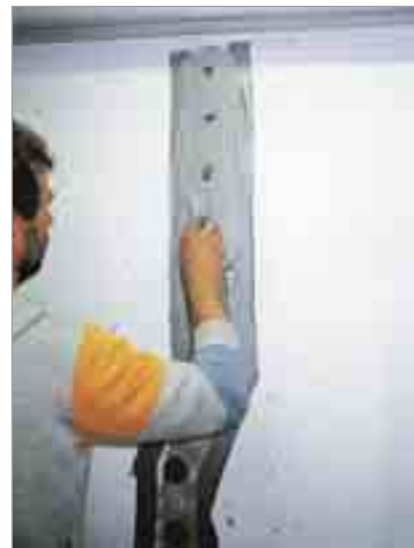
Klebpacker im Einsatz: Verdämmen des Risses
