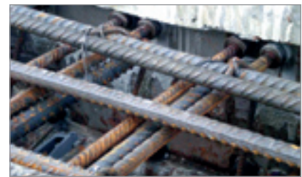
Exakte Bewehrungslage im 2. Betonierabschnitt durch einfache Montage der Coupler Anschlussstäbe in der Verzahnungsfuge.
