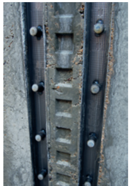
Betonierergebnis: Lage der Coupler-Muffen in der Verzahnungsfuge
