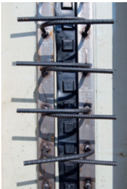
Vorkonfektionierte Coupler Bewehrungselemente im 1. BA mit zusätzlicher Verzahnung durch Fugenformprofil
