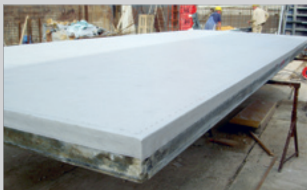
Mit Zemdrain® MD fertig bespannte Stahlrahmenschalung
