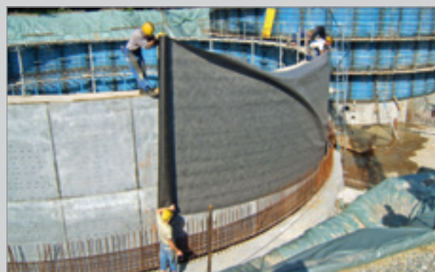
Spezielle Bespannung eines Stahlrundbehälters – Zemdrain® Classic wurde für diese Sonderschalung werkseits entsprechend vorkonfektioniert.
