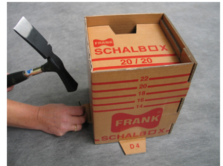
6. Aufnageln auf die Schalung mit Breitkopfnägeln (Dachpappestifte)
